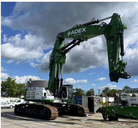
Sloopkraan die 23 juni a.s. wordt aangevoerd
