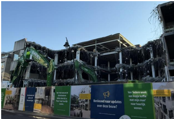
Foto links: stand sloopwerkzaamheden
