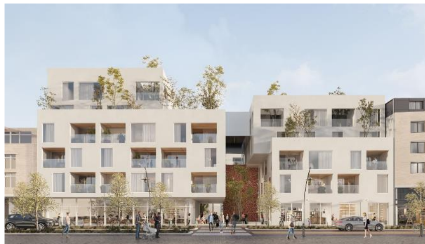
Nieuwbouw V&D locatie
