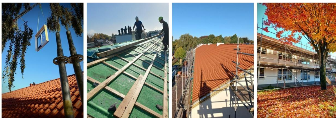
Impressie werkzaamheden On Site woningen
