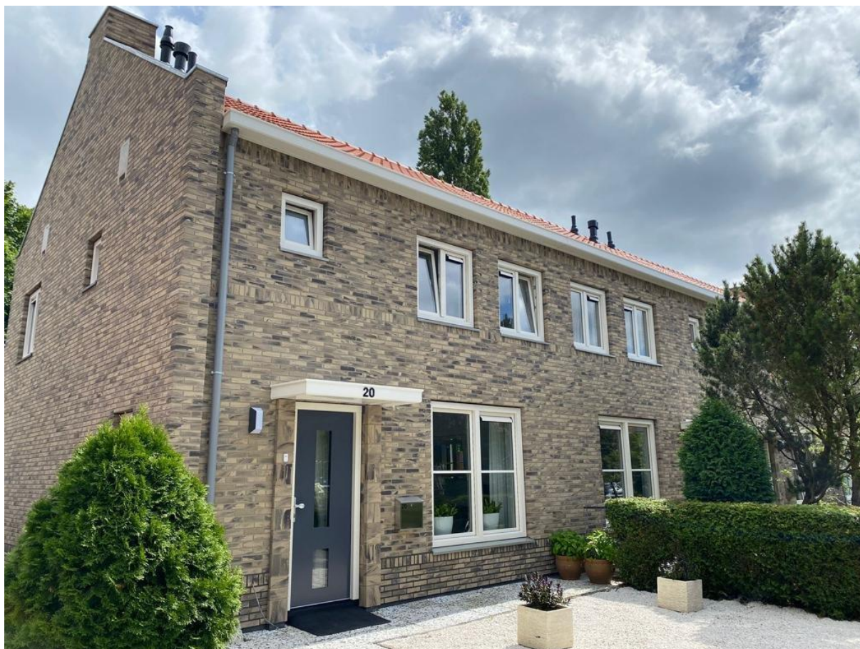
Eindresultaat verduurzamings- en renovatieproject Bilderdijklaan
