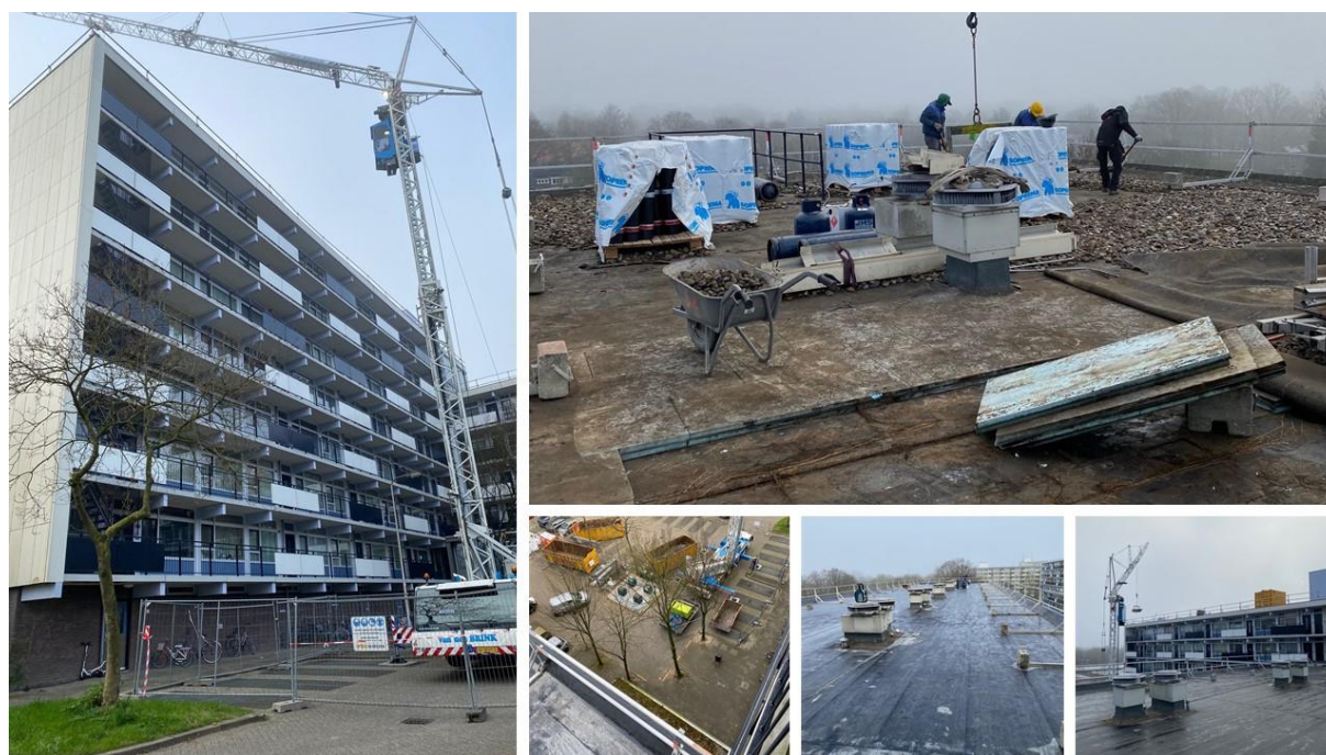
Dakrenovatie Couwenhoven flat 70
