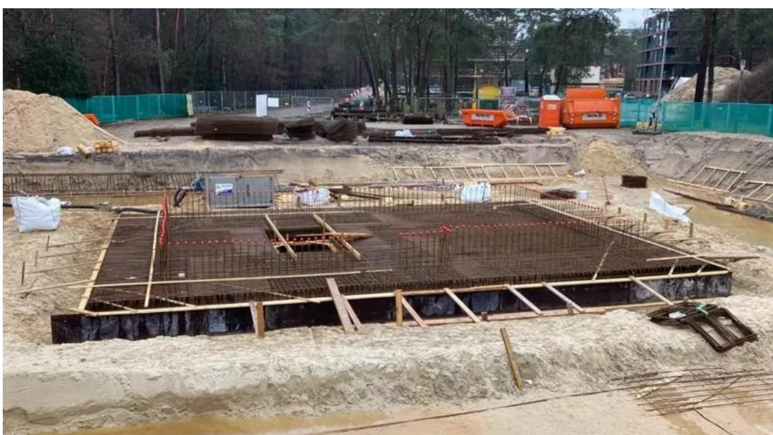
Foto start bouw
