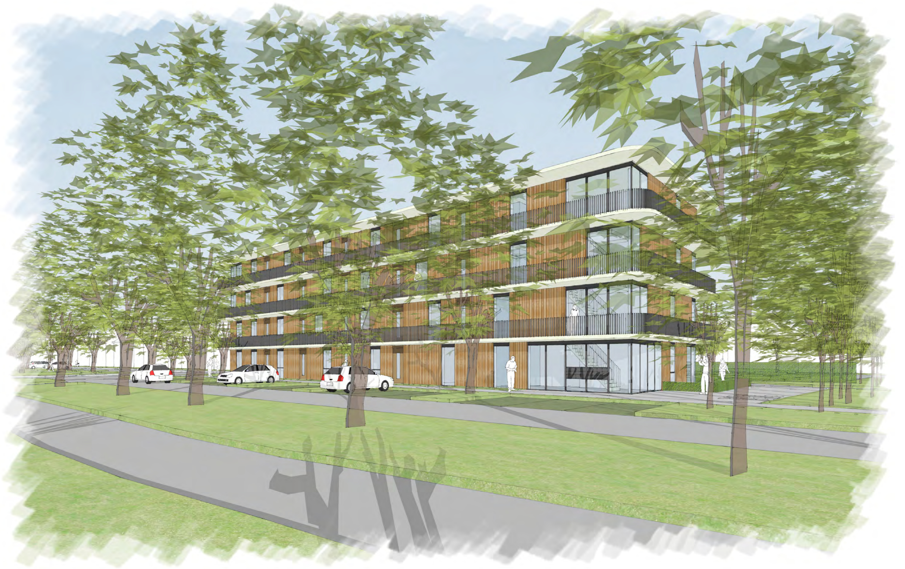
Schermerslaan, noordwest langsgel
