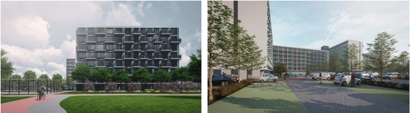
Impressies van de nieuwbouw naast Nijenheim flat 40 De Grift
