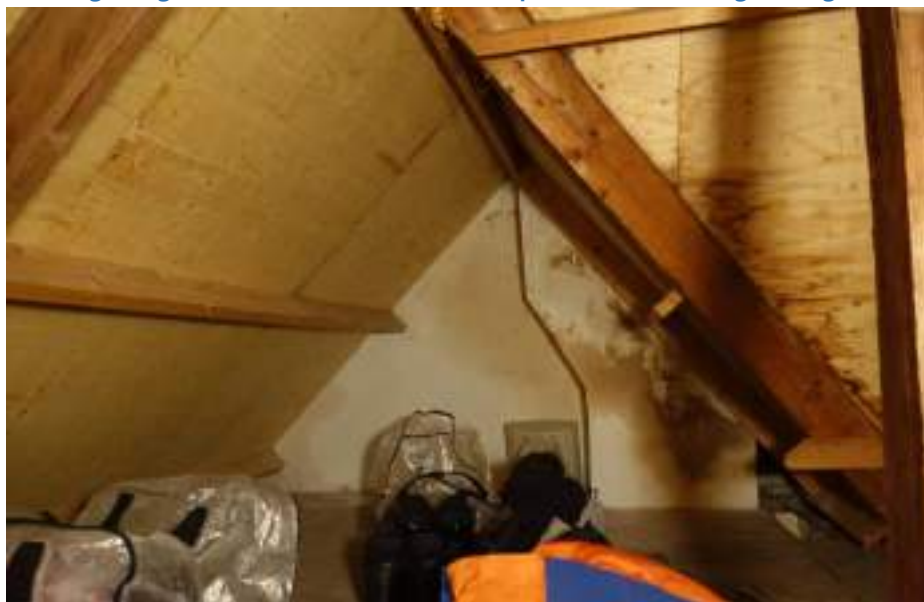
Nieuwe gordingen en dakbeschot en oude hoekkepers boven de woning Panweg 45.
