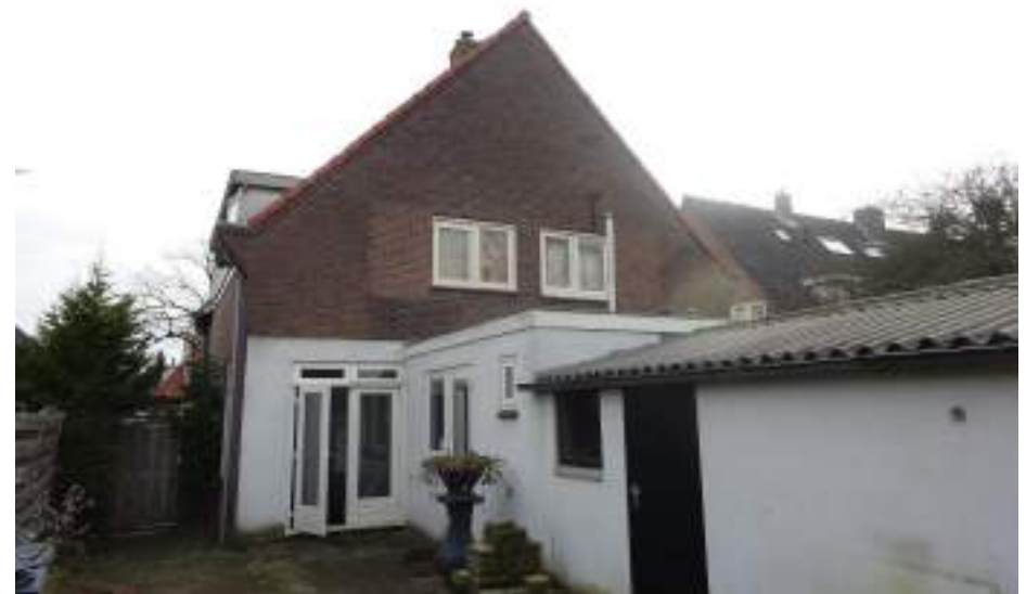
Aan de achterzijde van de woning is een oorspronkelijke uitbouw onder een plat dak en een latere aanbouw onder een lessenaarsdak aanwezig.
