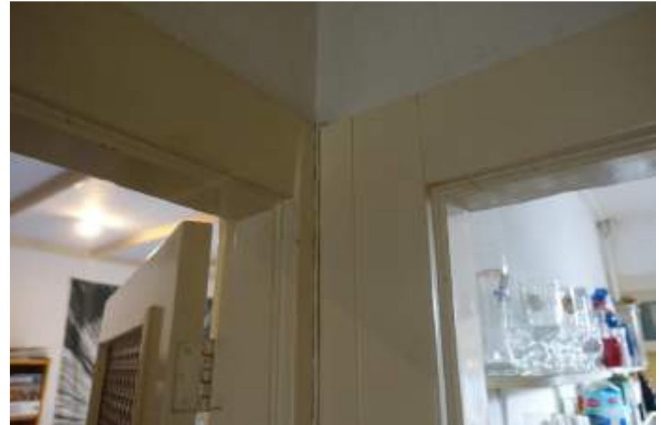
Detail van de oude kozijnen.
