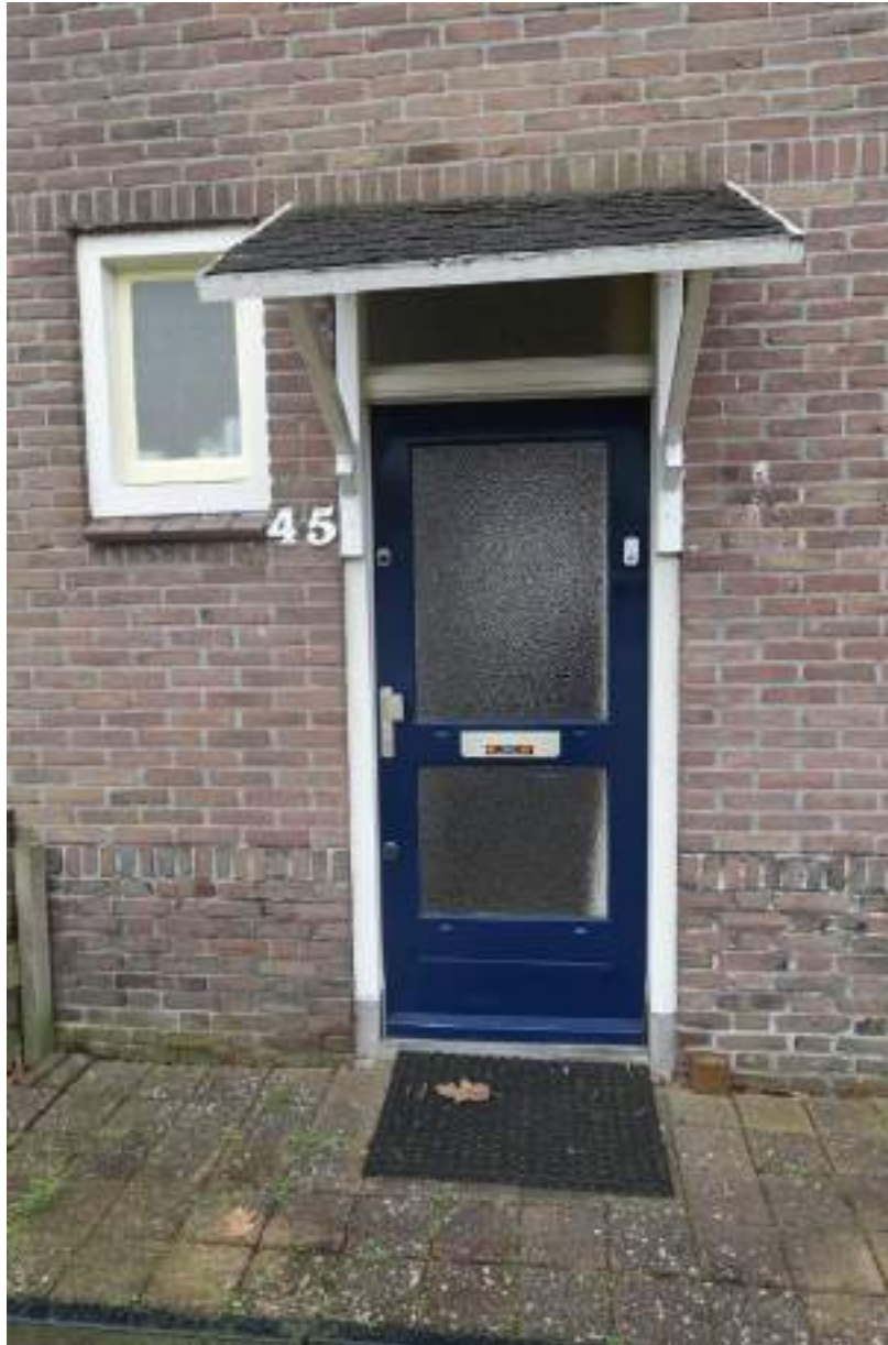
De entree deur in de voorgevel. Uitgevoerd met een oude luifel met moderne bedekking.
