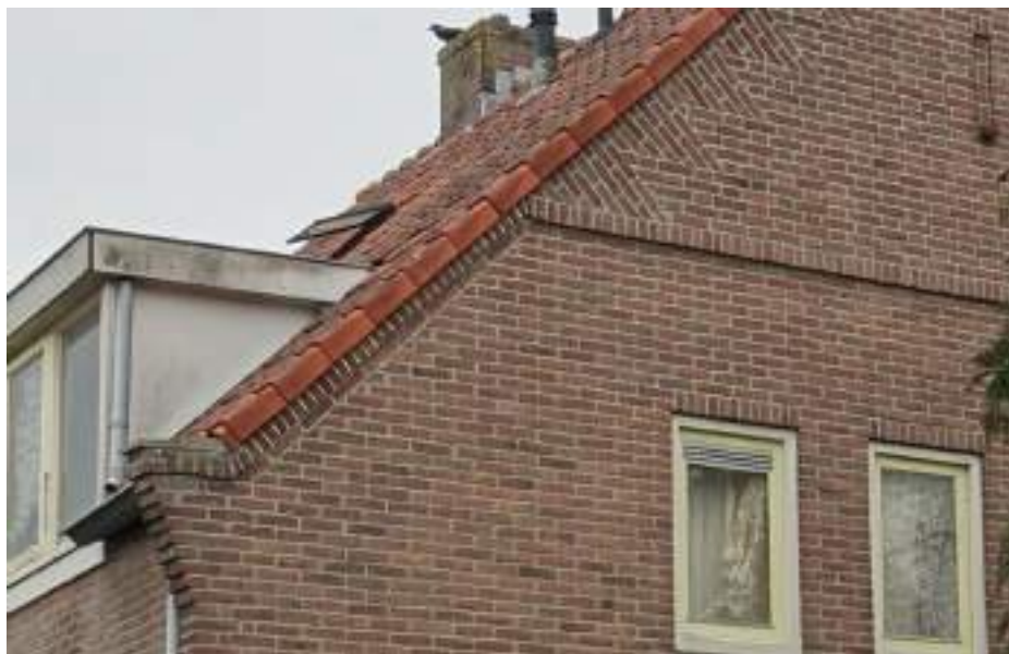
Baksteendecoraties bij de woningen aan de Patijnlaan: uitkragende schoulers, rollagen en vlechtwerk.
