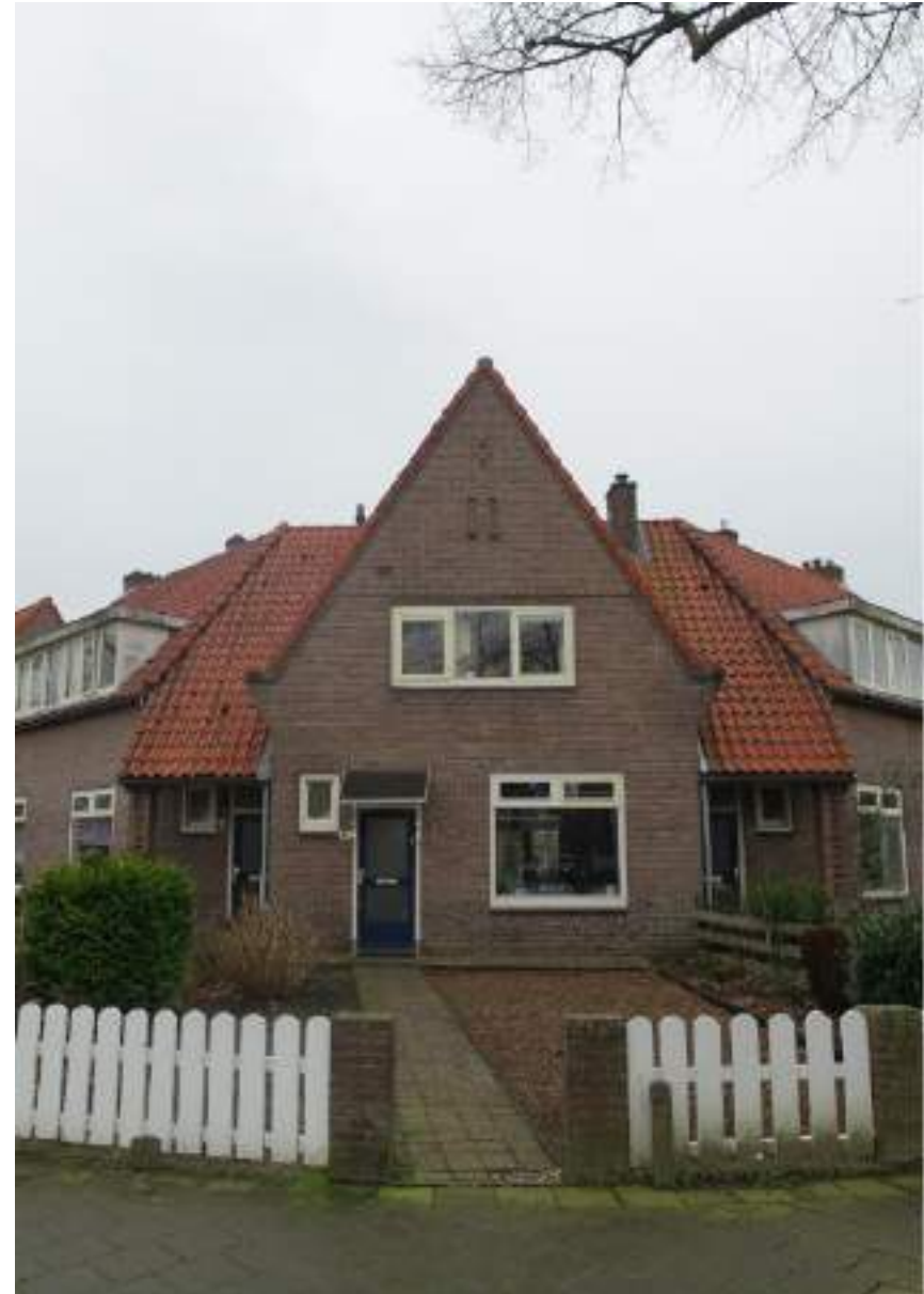
Voorzijde van Panweg 45 met links en rechts van de topgevel de portieken van de hoekwoningen.
