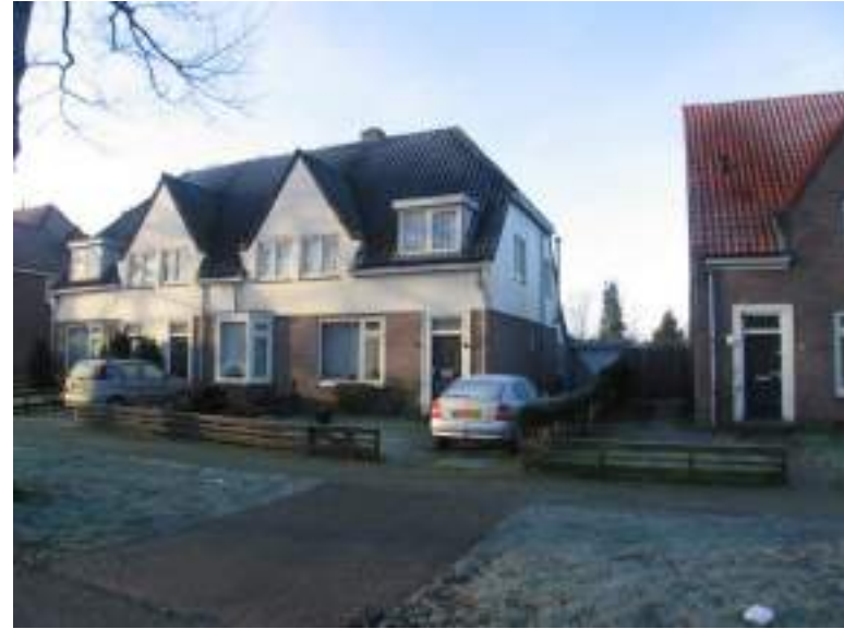
Type H'': Panweg 33-37, linker zijgevel, voorgevel en rechter zijgevel
