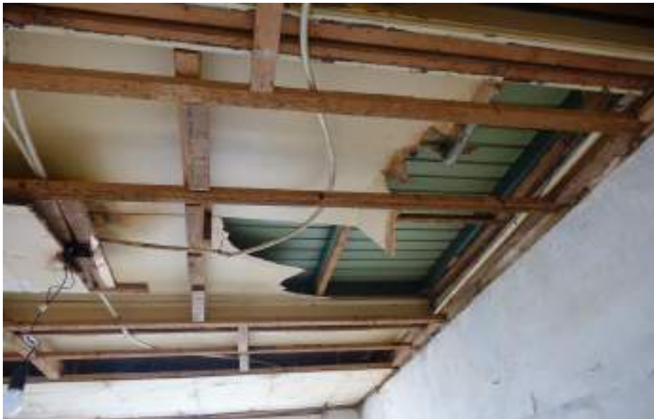
Het plafond boven de woonkamer bezit een reeks aan afwerkingen uit verschillende perioden.
