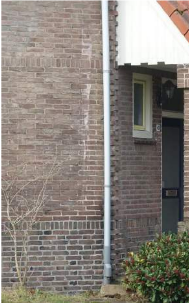
Detail van de muizentand bij de portieken van de hoekwoningen van het type D.
