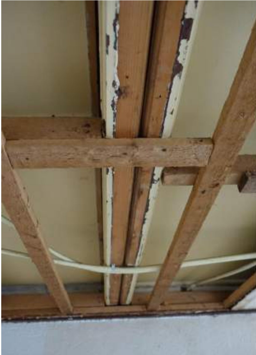
Detail van een enkelvoudige balklaag van de verdiepingsvloer bij Patijnlaan 11.
