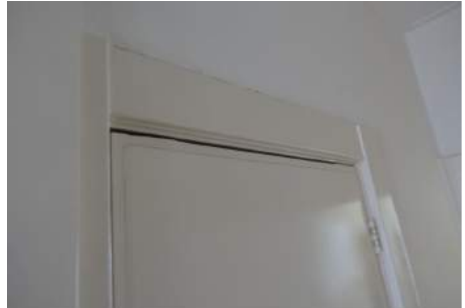
Detail van een oud kozijn in de doorgang naar het toilet. De deur is afgeplaat en mogelijk nog oud.
