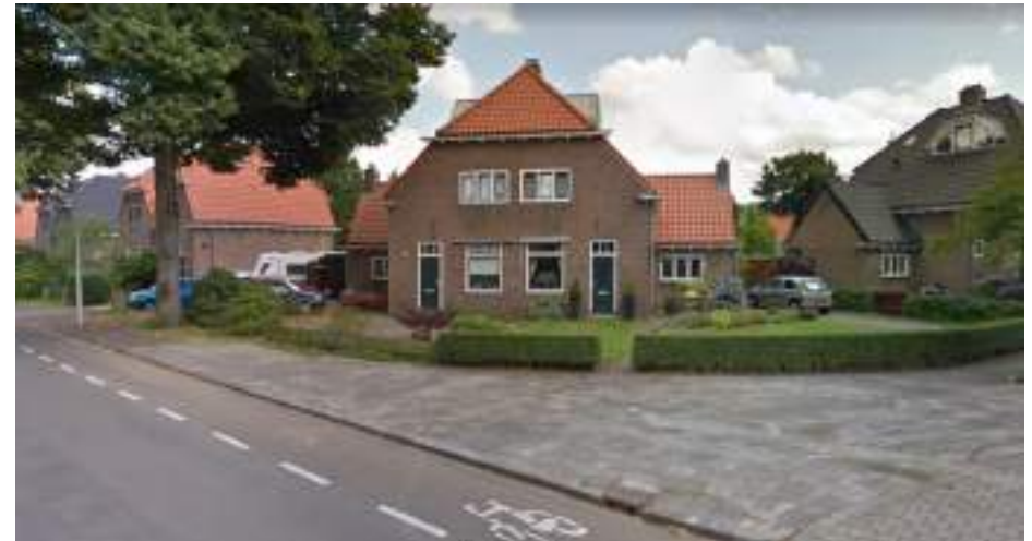
De hoek bij de kruising Bergweg – Alpacalaan. De woning is diagonaal geplaatst en de wegen sluiten via een breed trottoir op elkaar aan. Google Maps.
