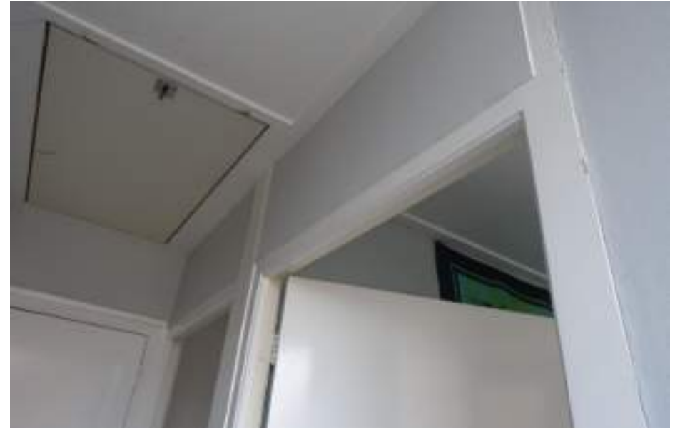
Detail van de vernieuwde doorgangen op de zolderverdieping.
