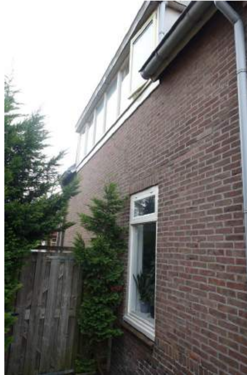
Het venster in de zijgevel is nog oud, de vulling is vernieuwd.
