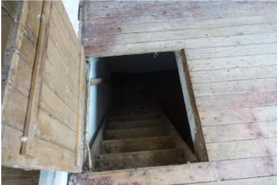
Het kelderluik in de begane grond vloer van de keuken.
