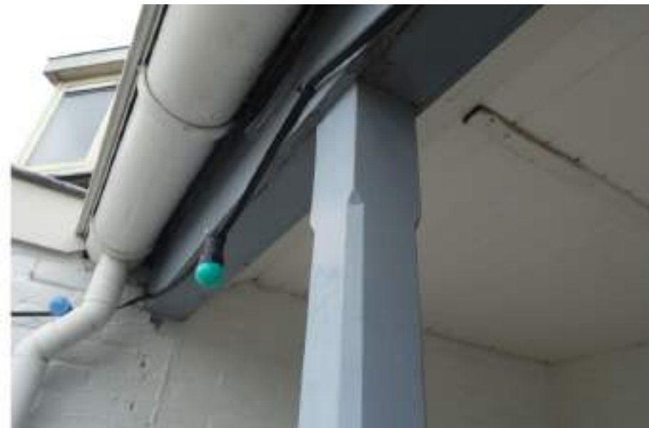
Detail van de houten kolom die het dak van de veranda ondersteunt.
