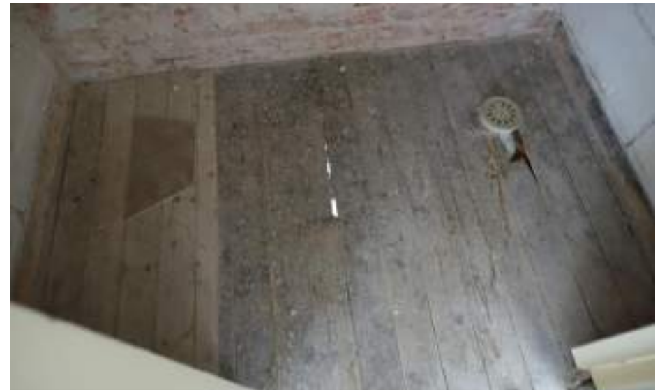
De dekvloeren geven soms informatie weer van oude indelingen. Zo is op de verdieping van Patijnlaan 11 de positie van een inbouwkast te herkennen in het licht geschilderde vlak.
