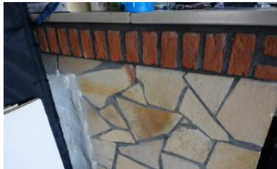
Detail van de schouw in de achterste slaapkamer.
