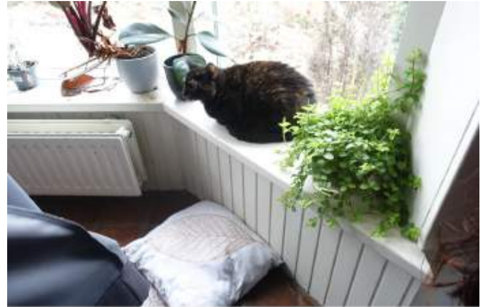
De schroten lambrisering bij de erker.
