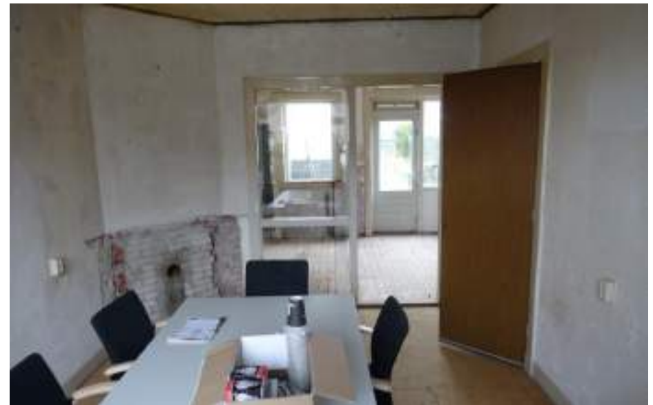
De woonkamer gezien richting de achtergevel. Het rookkanaal van de hoekschouw stamt uit 1966. Bij de deur is de trapkast.
