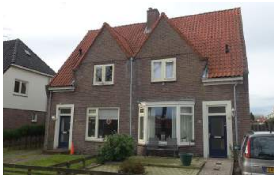
Een woning met erker van het type H aan de Panweg met topgevels centraal tegen de voorgevel
