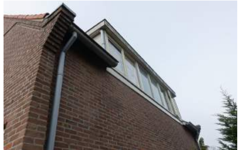
De moderne dakkapel aan de zijkant van de woning.
