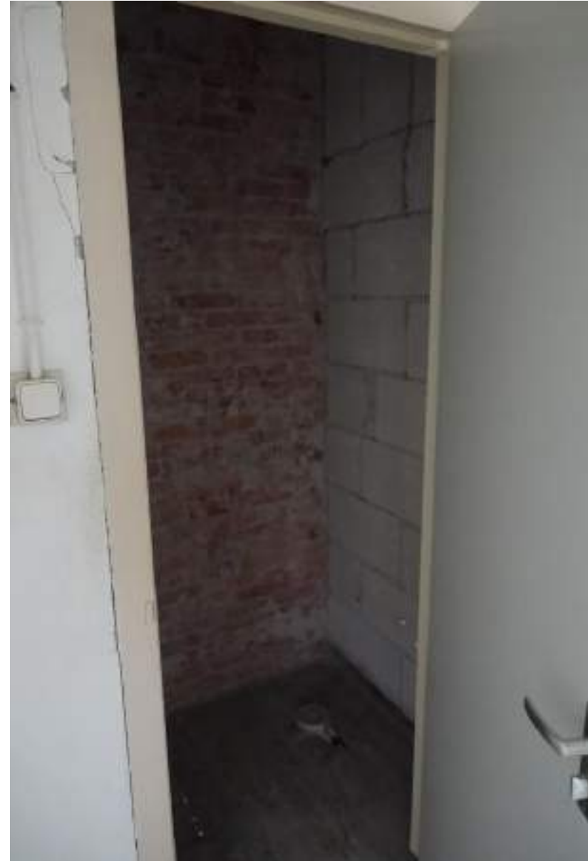
De badkamer heeft binnenmuren van gasbetonblokken.
