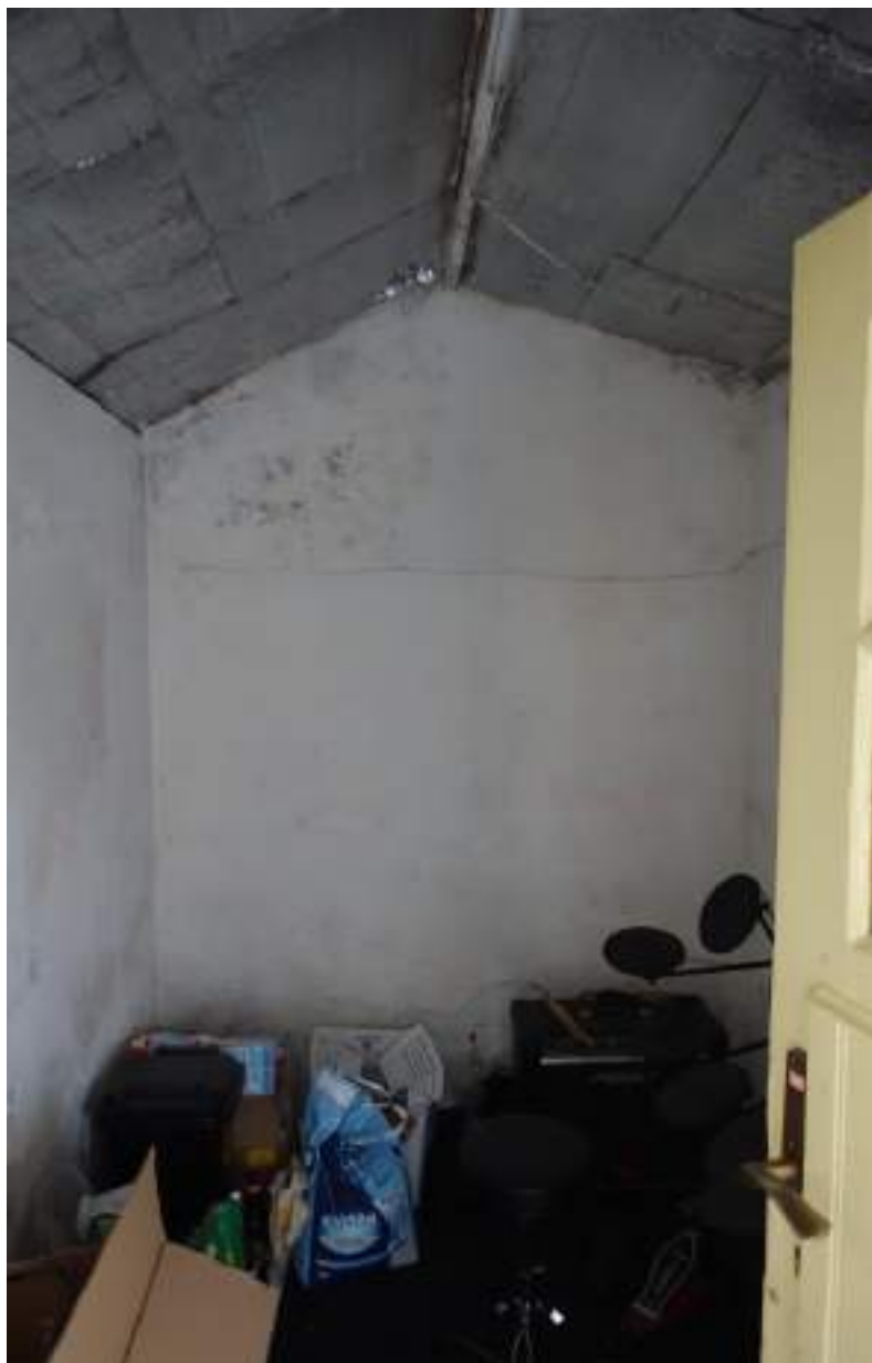
De binnenzijde van de oude schuur.
