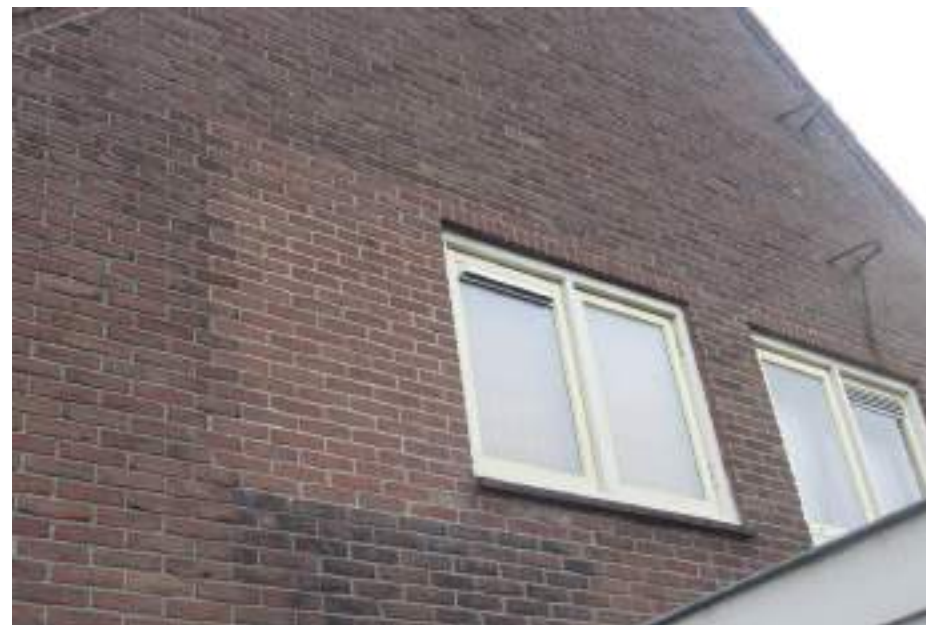
Een aangepast venster op de verdieping in de achtergevel van Dijnselweg 47.
