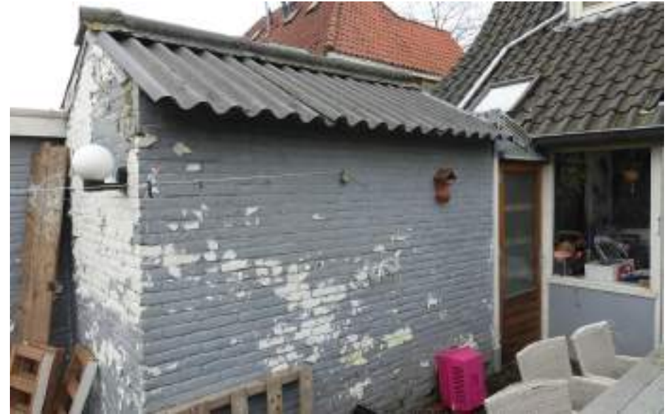
De van oorsprong losstaande schuur uit 1920. Bij de deur is de latere overkapping zichtbaar.
