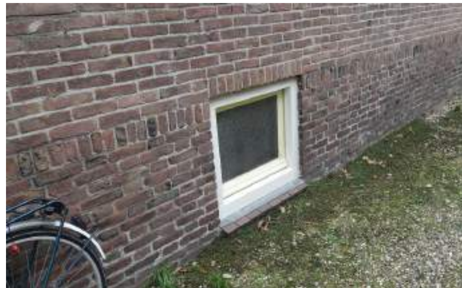
Het kelderlicht in de zijgevel behoort tot de oude opzet. De vulling is van 1966 of daarna.
