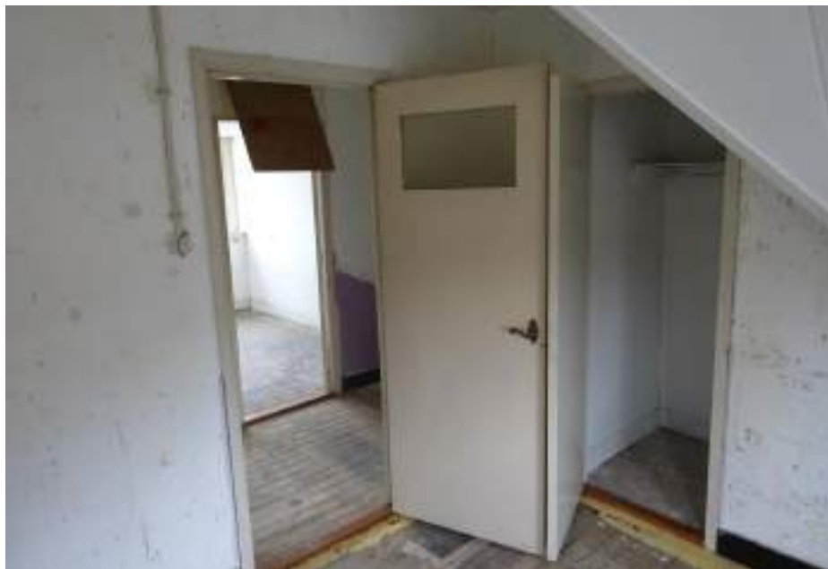
De doorgang van de kamer aan de voorzijde naar de overloop met jonger kozijn en deur. Ook de inbouwkast is uit een jongere periode.
