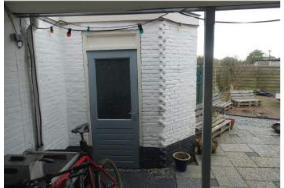
De schuur in de achtertuin is onderdeel van de opzet van 1920-1921. De deur is ooit vernieuwd.
