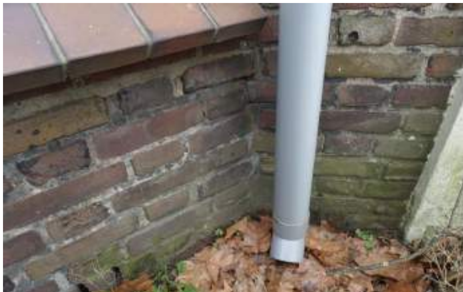
Detail van de bakstenen borstwering van de erker die uit een soortgelijke oorspronkelijke steen bestaat als de voorgevel.
