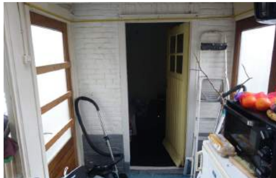
Door de overkapping van de ruimte tussen de schuur en veranda is de schuur nu binnenshuis komen te liggen. De entree deur tot de schuur is oud.
