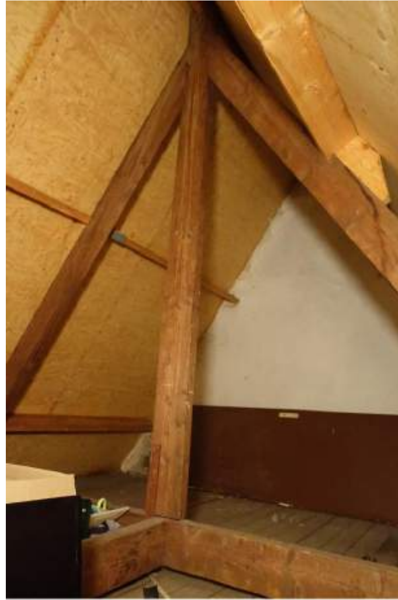
De spanten met nokstijl boven Panweg 45.
