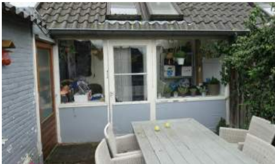
De dichtgezette veranda aan de achterzijde.
