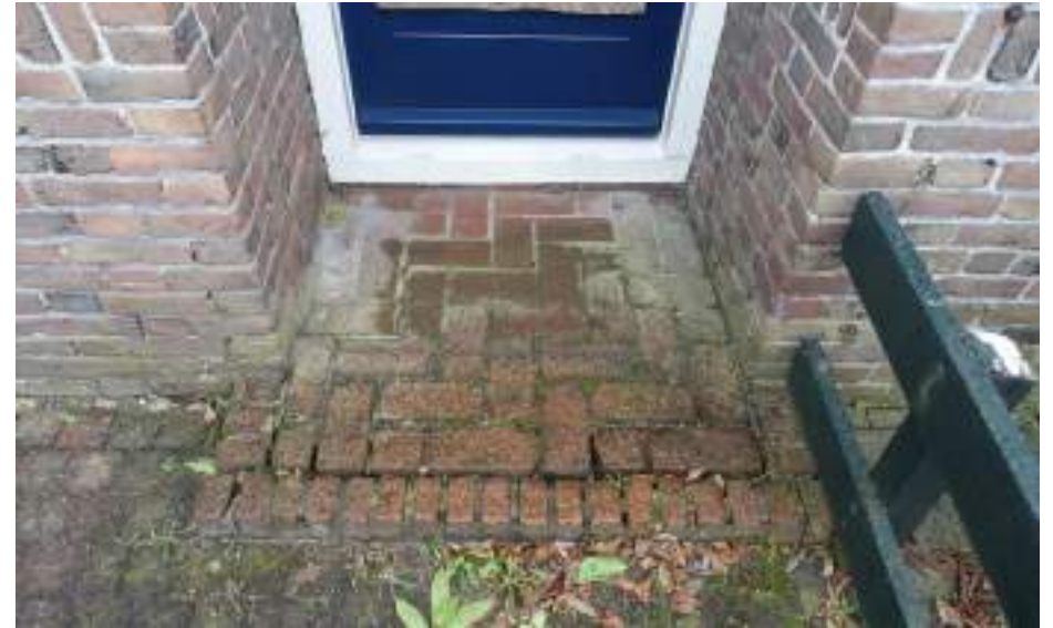
Detail van de baksteen vloer voor de entree in de voorgevel.
