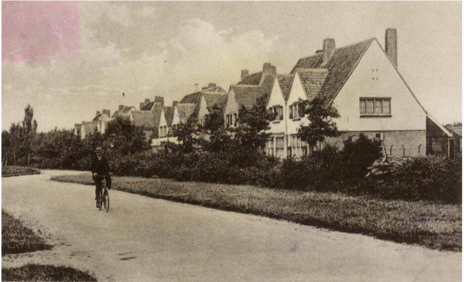
De Panweg omstreeks 1925 met zicht op de woningen met nummer 24-26 en verder van het type H. Opvallend zijn de witgepleisterde delen aan de bovenzijde van de gevels. Ook vallen de baksteen schoorstenen op die aan de voor- en achterzijde boven de nok van het dak uitsteken. De raamluiken zijn geschilderd in een geometrisch patroon. UA beeldbank, nr. 15620.
