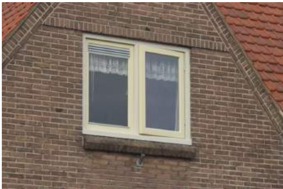
Op de verdieping van Dijnselweg 35 is een oorspronkelijke bakstenen lekdorpel aanwezig.
