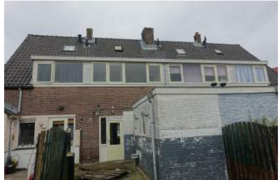
Zicht op de achtergevel met jonge dakkapel en oorspronkelijke uitbouw.
