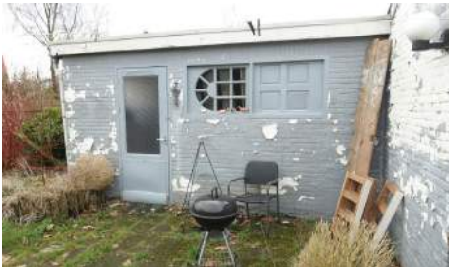
De zijgevel van de garage richting de tuin met entree en venster.
