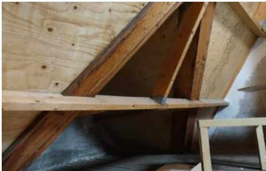
Nieuwe gordingen en dakbeschot en oude hoekkepers boven de woning Panweg 44.
