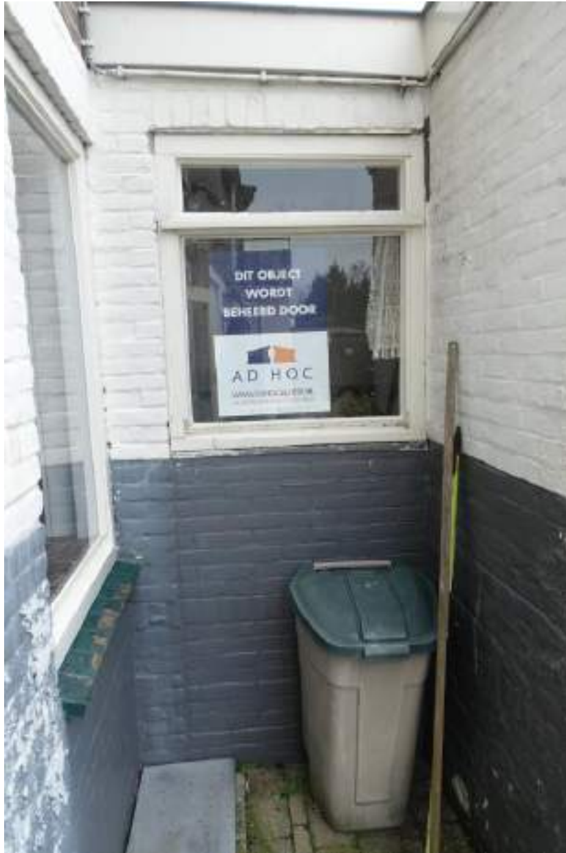
Tussen de woning en de uitbouw aan de achterzijde is een smal verbindingslid.
