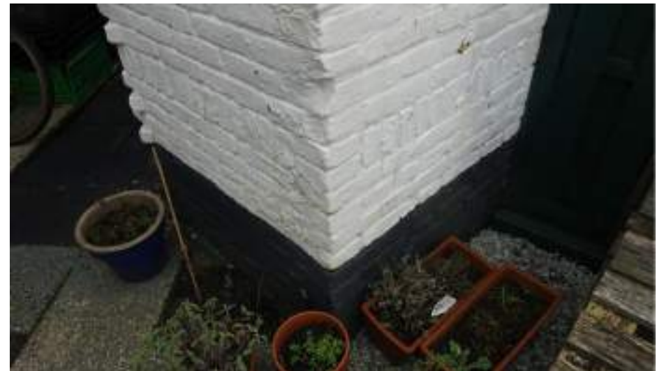
Detail van het gevelwerk van de schuur in de achtertuin.
