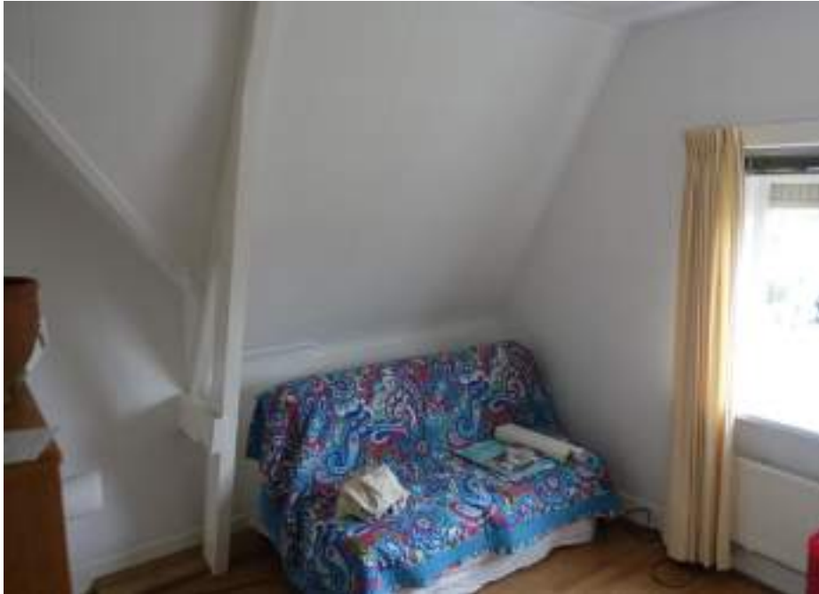
Een Hollands spant met kreupele stijl in de woning Panweg 45.
