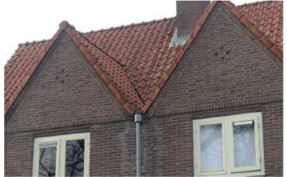
Baksteendecoraties in de vorm van een ruit en rollaag bij de woningen aan de Panweg.
