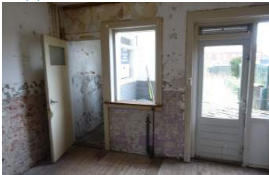
De keuken gezien richting achtergevel.
