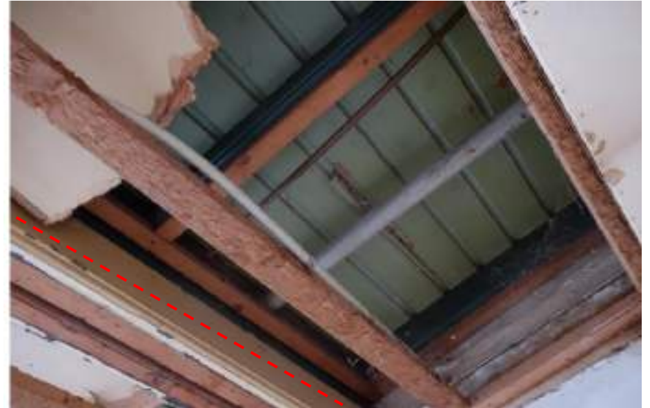
De oorspronkelijke plafondaafwerking boven de woonkamer bestond uit enkelvoudige balken (rode lijn) waartussen vakken waren gemaakt van dwarsbalken met een vulling van schroten. De afwerking van licht en donkergroen is oud maar niet oorspronkelijk.
