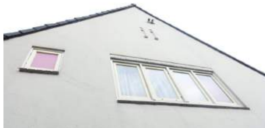
Detail van de gepleisterde zijgevel op zolderniveau met rechts moderne vullingen in oude vensteropeningen. Het venster links is in 1966 aangebracht toen hier een badkamer werd gemaakt.
