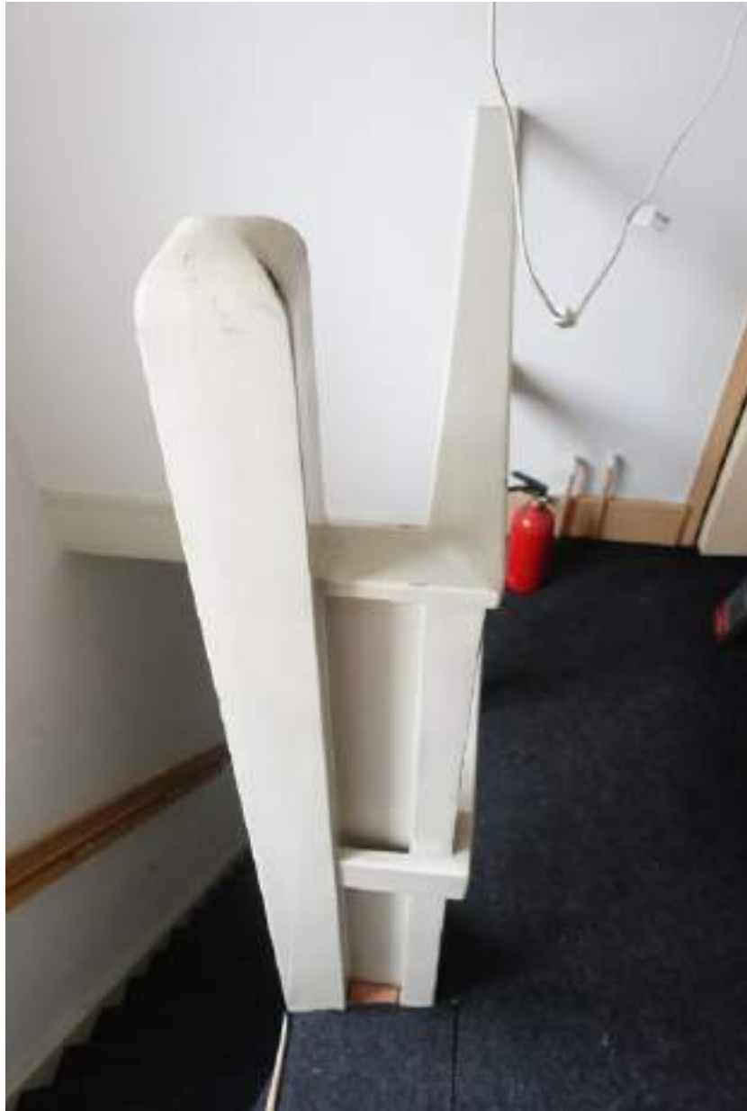
De trappaal met houten hekje aan de bovenzijde van het trapgat.
