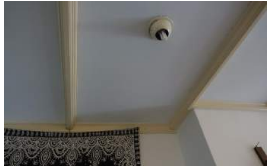
Boven de woonkamer is de oude enkelvoudige balklaag nog zichtbaar.
