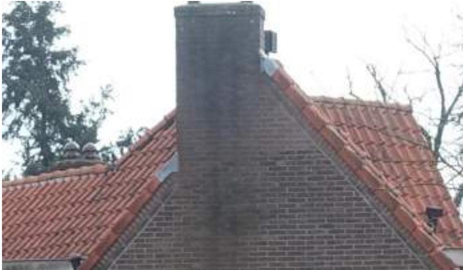
De deels nieuw opgemetselde schoorsteen bij het type D (Panweg 24).
