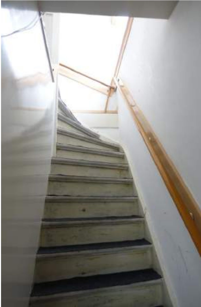
De trap naar de zolderverdieping.
