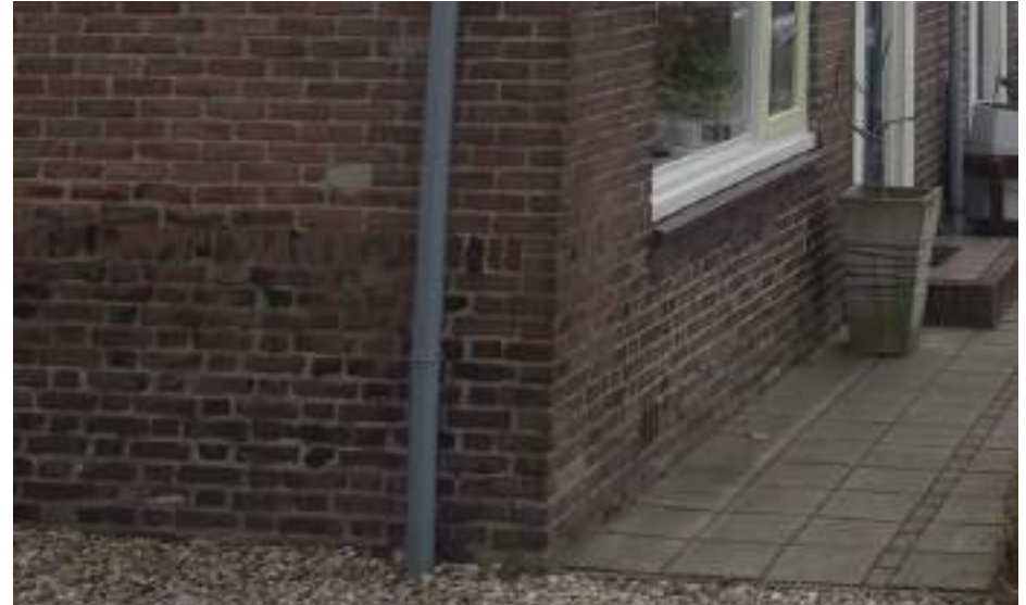
Detail van het metselwerk: een trasraam in Vlaams verband en opgaand werk in halfsteensverband.
