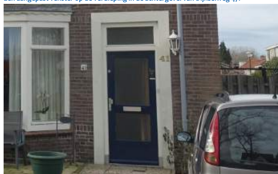
Een in 1966 of later aangebrachte deur in de hoofdentree bij Panweg 41.
