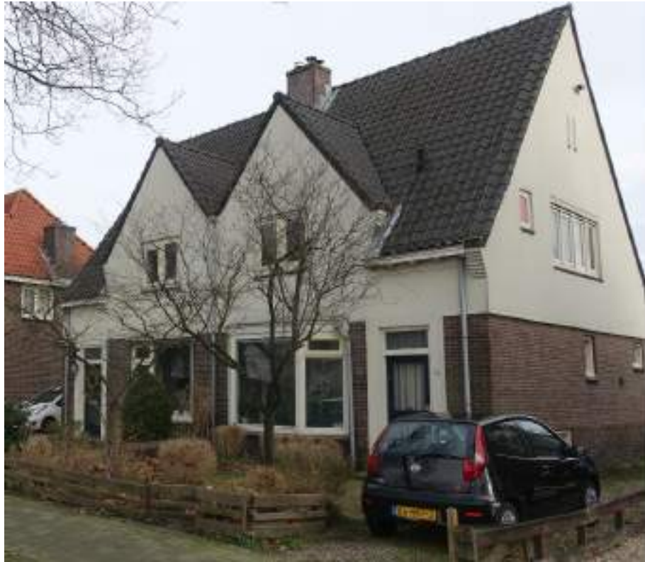
De woning Panweg 44-46, uitgevoerd met oprit.
