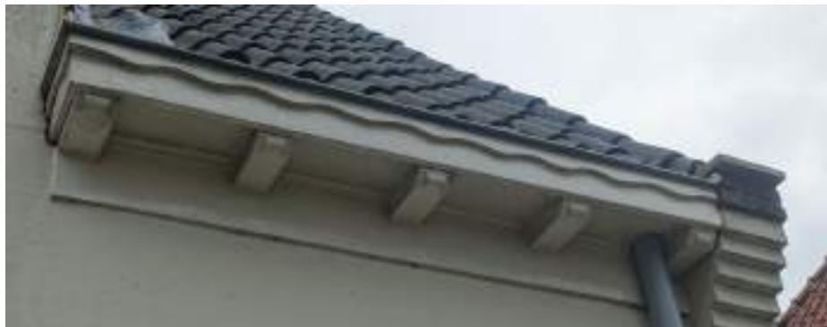
Detail van de goot op klossen met aan de voorzijde de golvende lijst.
