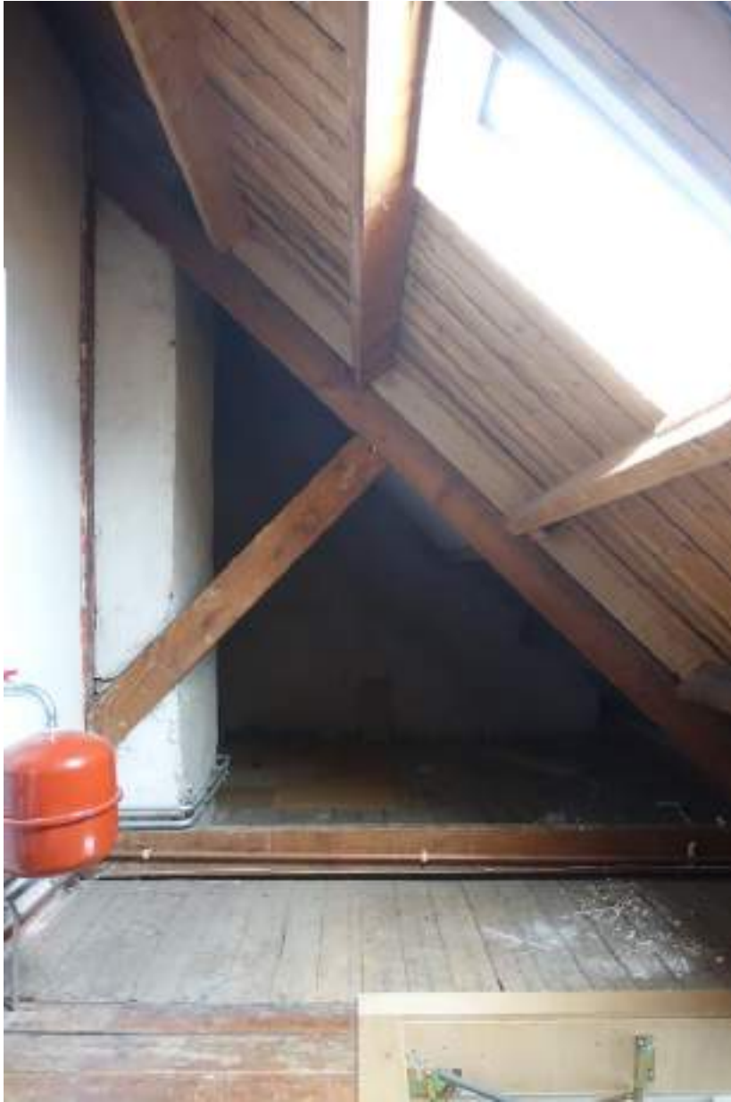
De geschoorde nokstijl boven Dijnselweg 47.
