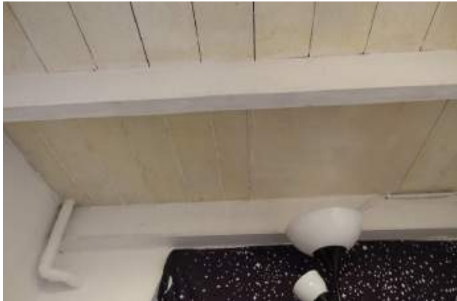
Een enkelvoudige balklaag van de begane grondvloer bij Panweg 44.
