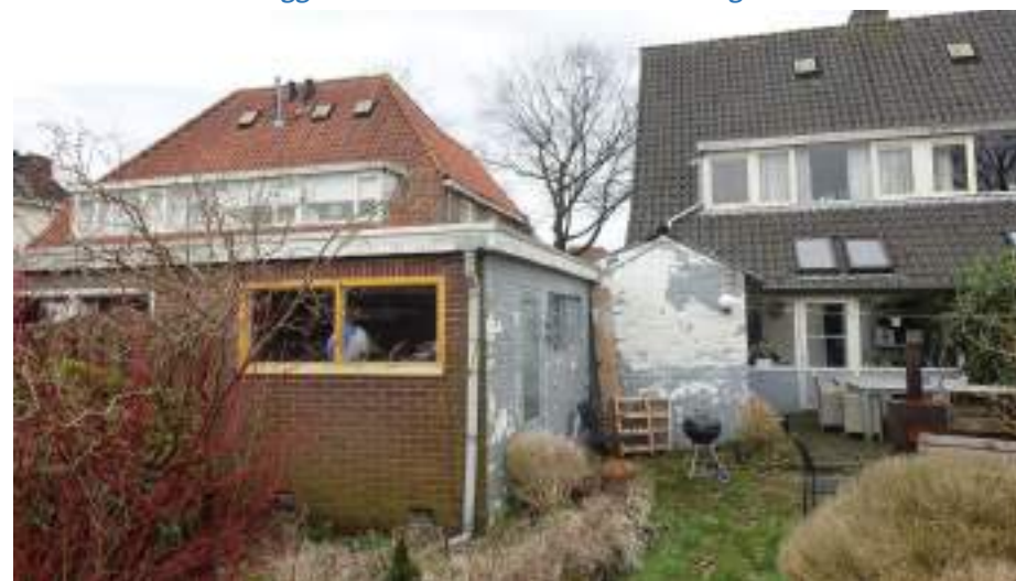
Overzicht van de verschillende bouwdelen aan de achterzijde van de woning, gezien vanuit de tuin.
