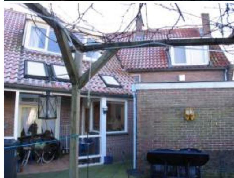
Type D: Panweg 22-24 en Dijnsweg 33, onder de achterzijde van Panweg 22
