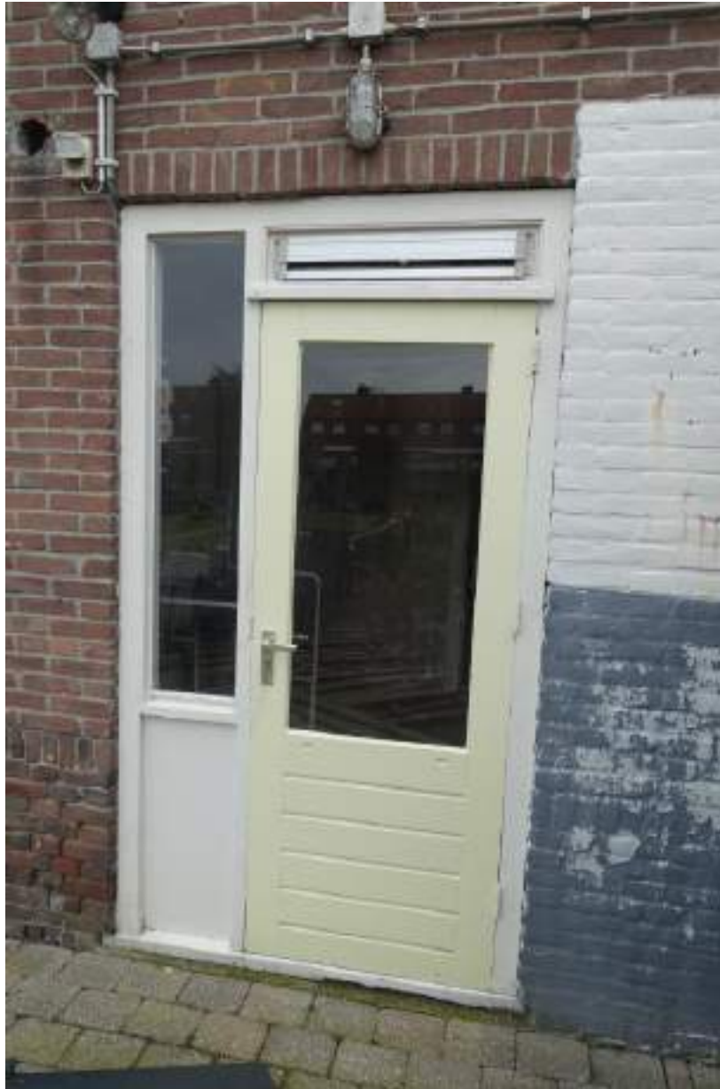
De nieuwe vulling in de achtergevel.
