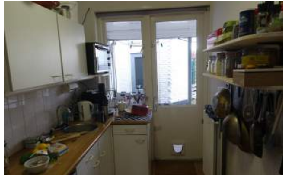
De indeling van een deur met zijlicht in de achtergevel van Panweg 45 behoort tot de oude opzet, hoewel de huidige vullingen wel ooit vernieuwd zijn.
