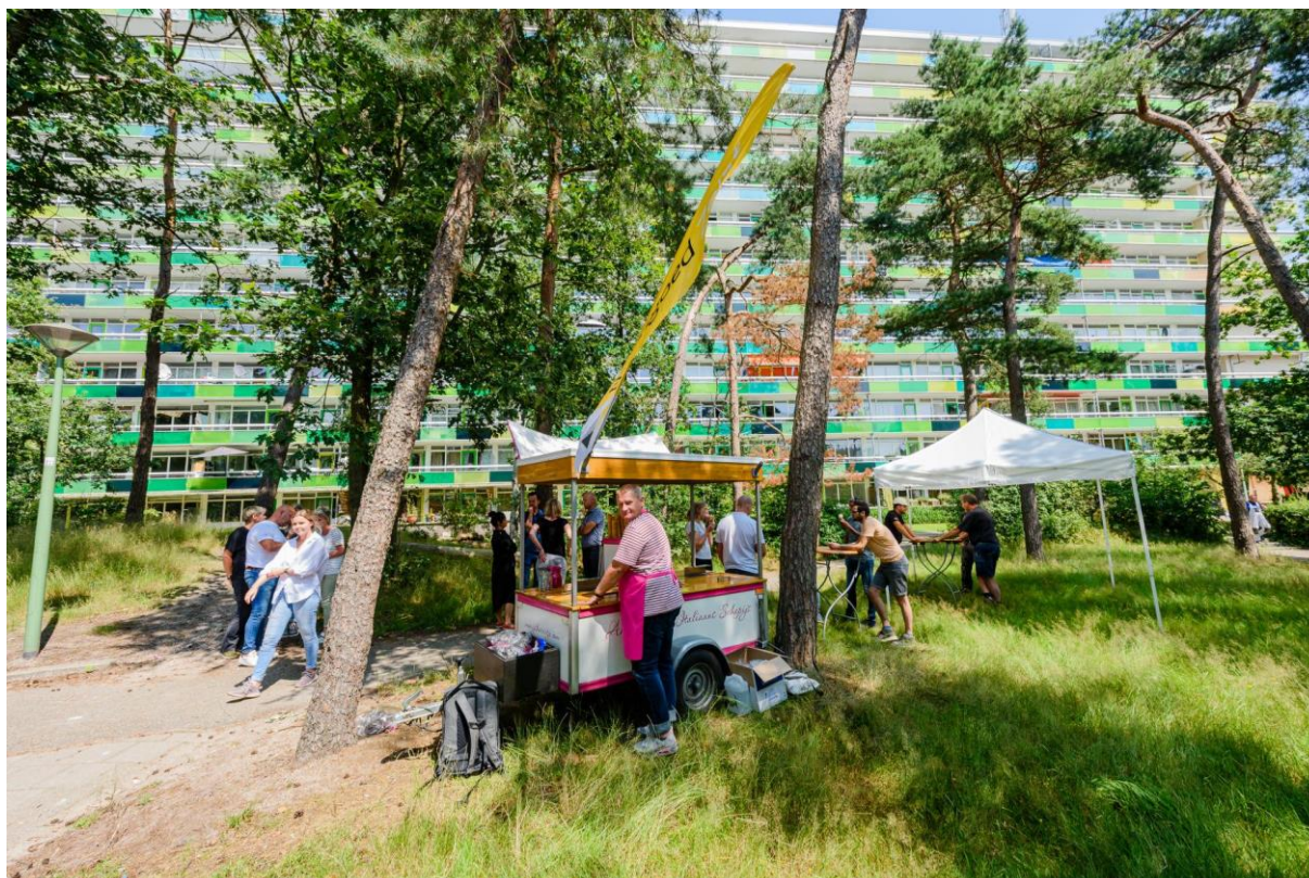
We vierden de oplevering van de eerste 135 vernieuwde woningen in de L-flat met ijs.
